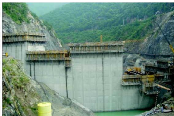
在建的 Tsankov Kamak 大坝(主河床坝段)
