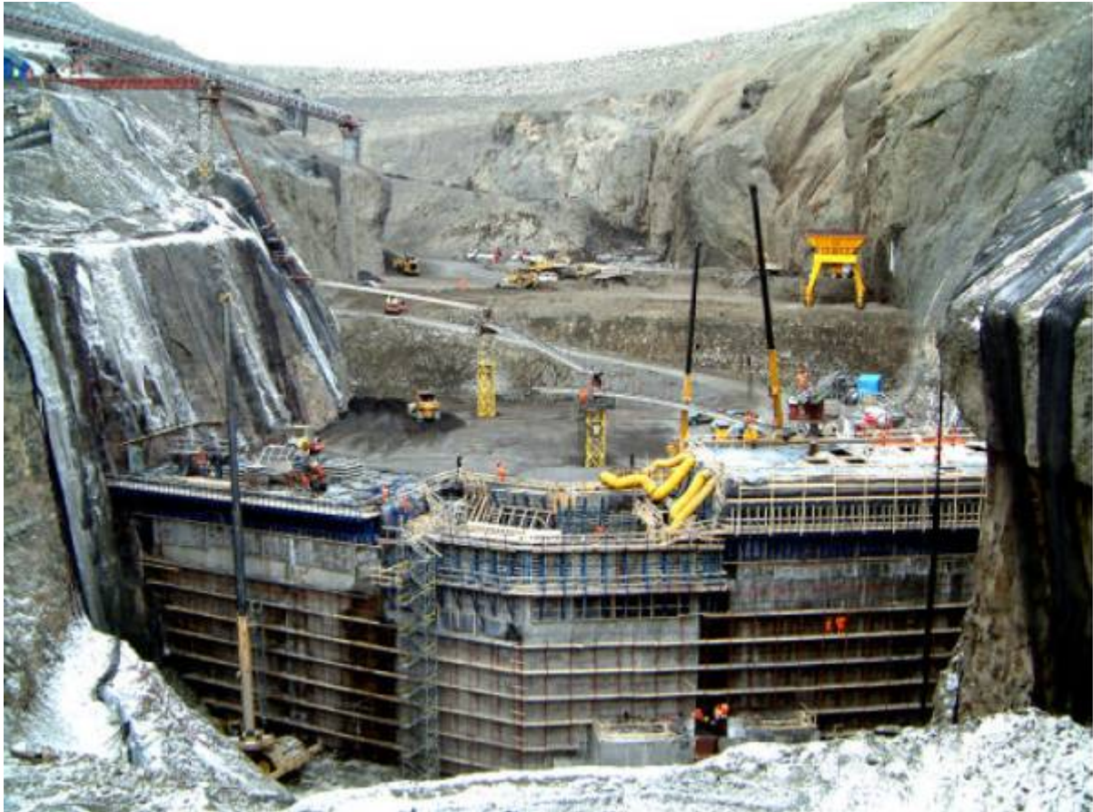
主坝趾墙的施工
