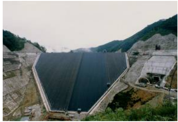
施工现场(正在进行面板铺筑)
