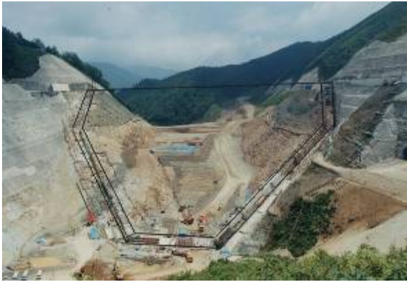
施工现场（正在进行开挖）
