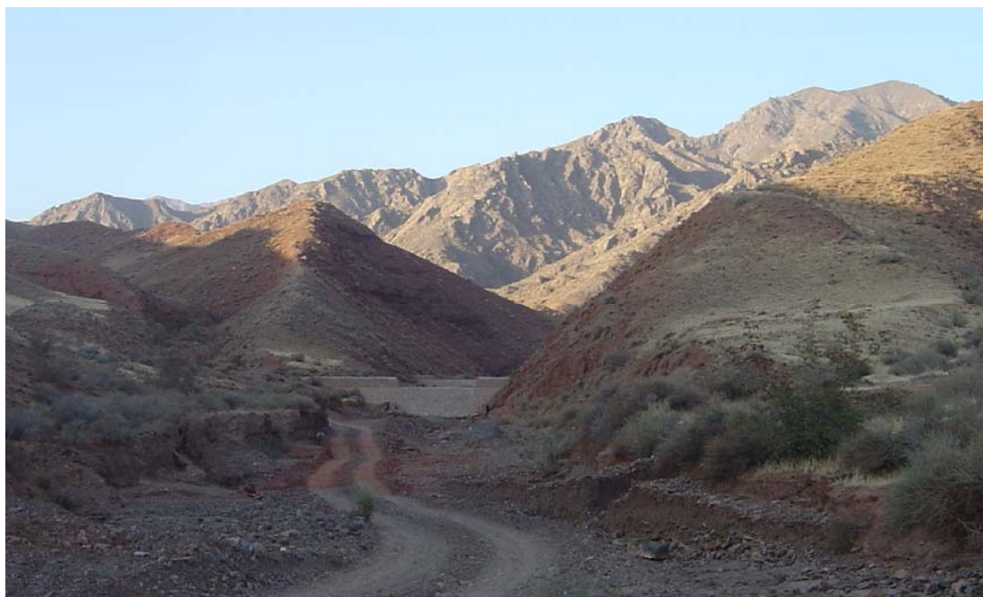
水土保持措施之一——在溪沟上建拦沙坝
