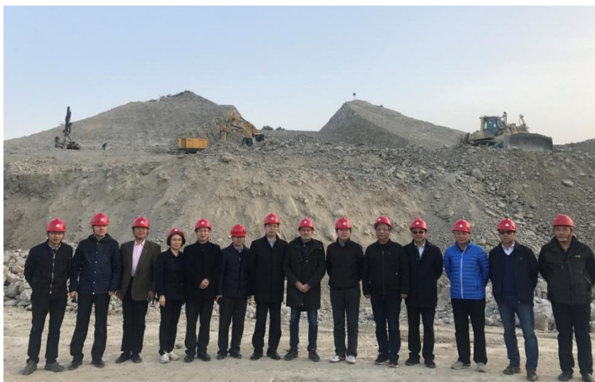
梅莱格大坝坝肩开挖现场查看
