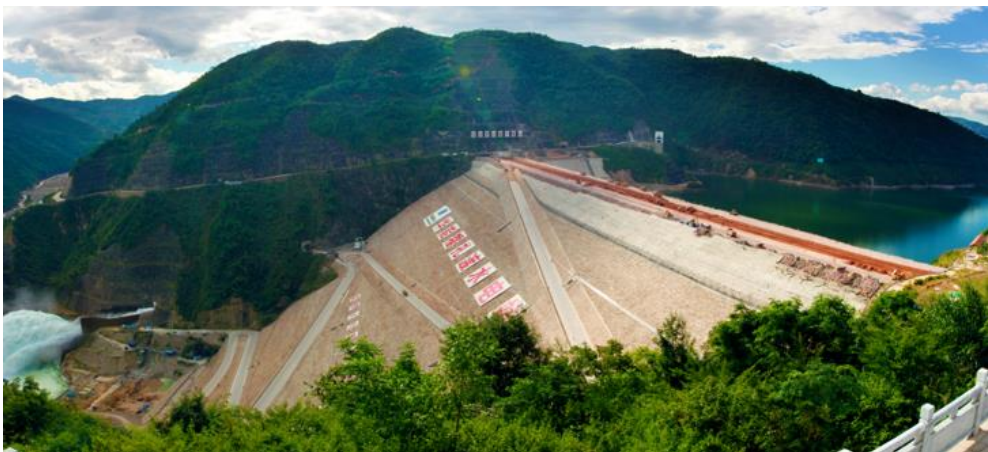
糯扎渡水电站工程
