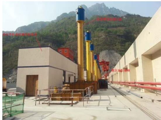
锁定平台包括位于事故闸门上游的上游锁定平台和位于事故闸门下游的下游锁定平台，上、下两个锁定平台设置通长锁定梁轨道，事故闸门两侧的锁定平台之间设有锁定梁，锁定梁两端分别与上游锁定平台和下游锁定平台上的轨道滚动连
