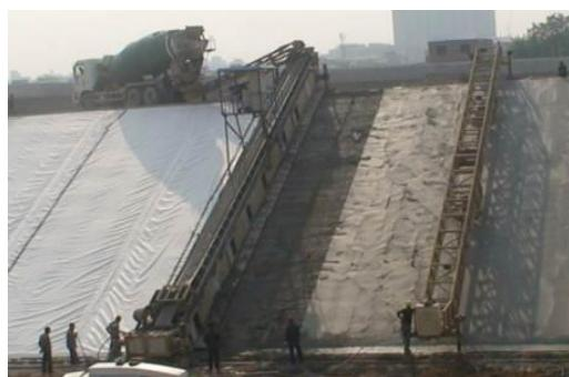
图2 衬砌机械化施工
