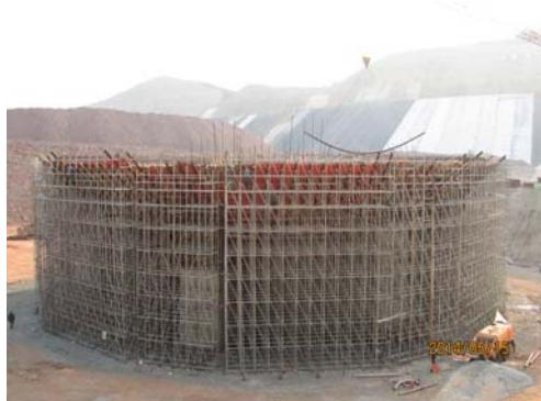
底座段上部 10m 高的倒坡斜锥体混凝土引入了国际上最为先进的支撑架体系—承插式盘扣架，并设计了一套施工速度快、抗倾覆能力强、稳定性高的大型宽幅闭环式模板支撑体系，解决了倒坡混凝土浇筑过程中水平推力下的架体变形难题，为国内水电工程中首创。
