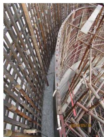
段内部椭圆曲线过流面的混凝土浇筑难题。底座段椭圆曲线过流面自行设计的梯形可调节组合模板为国内首创。
