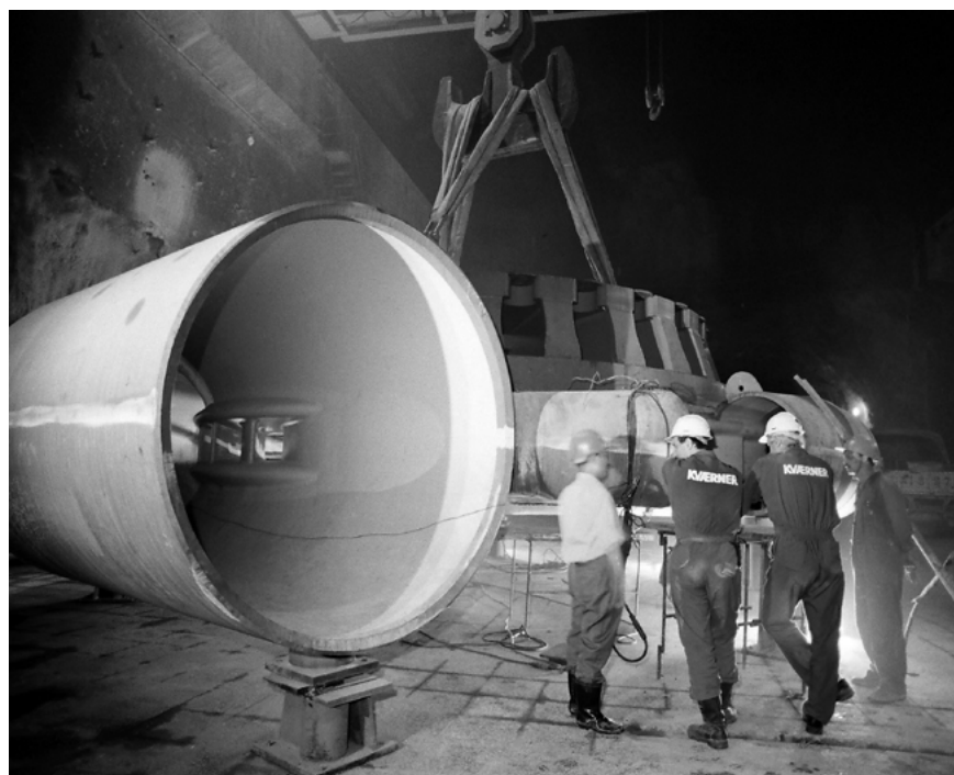
水泵水轮机安装
