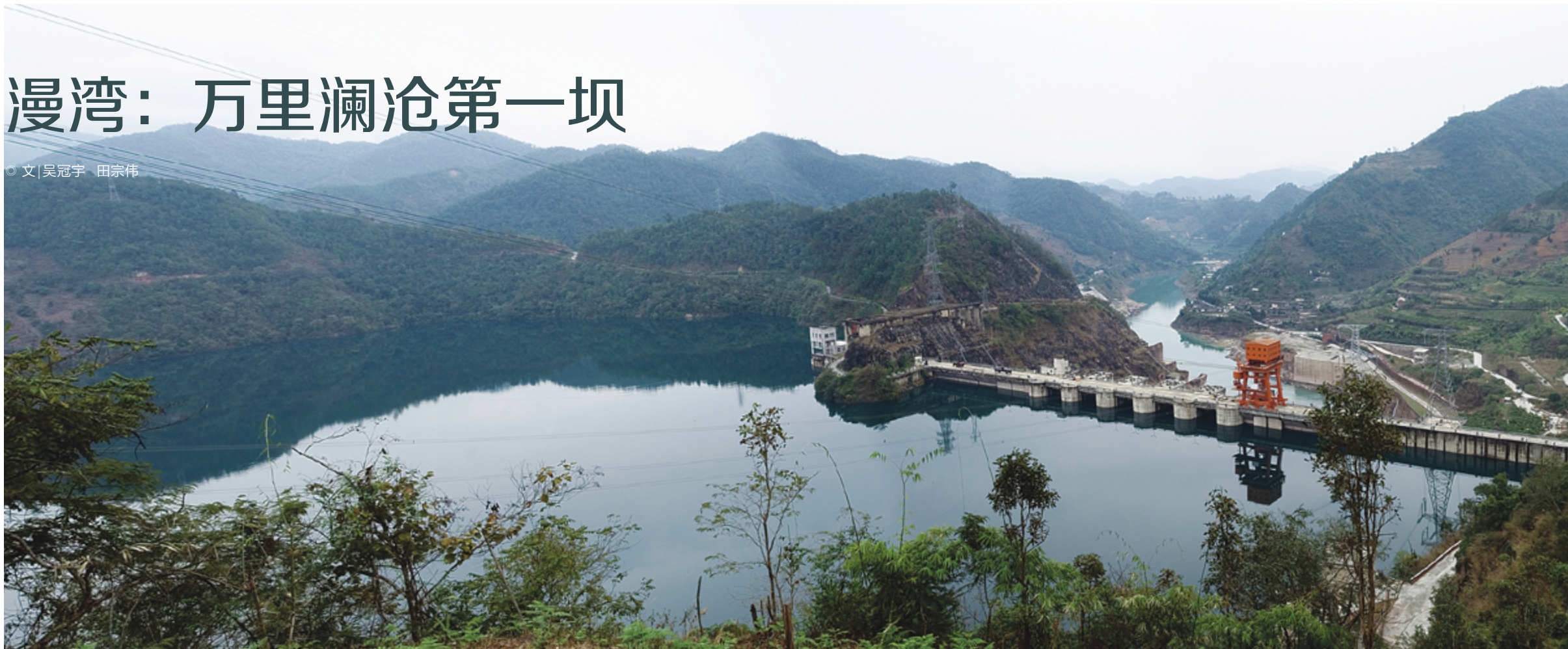
青山绿水间的漫湾电站大坝 供图 / 华能澜沧江水电公司
