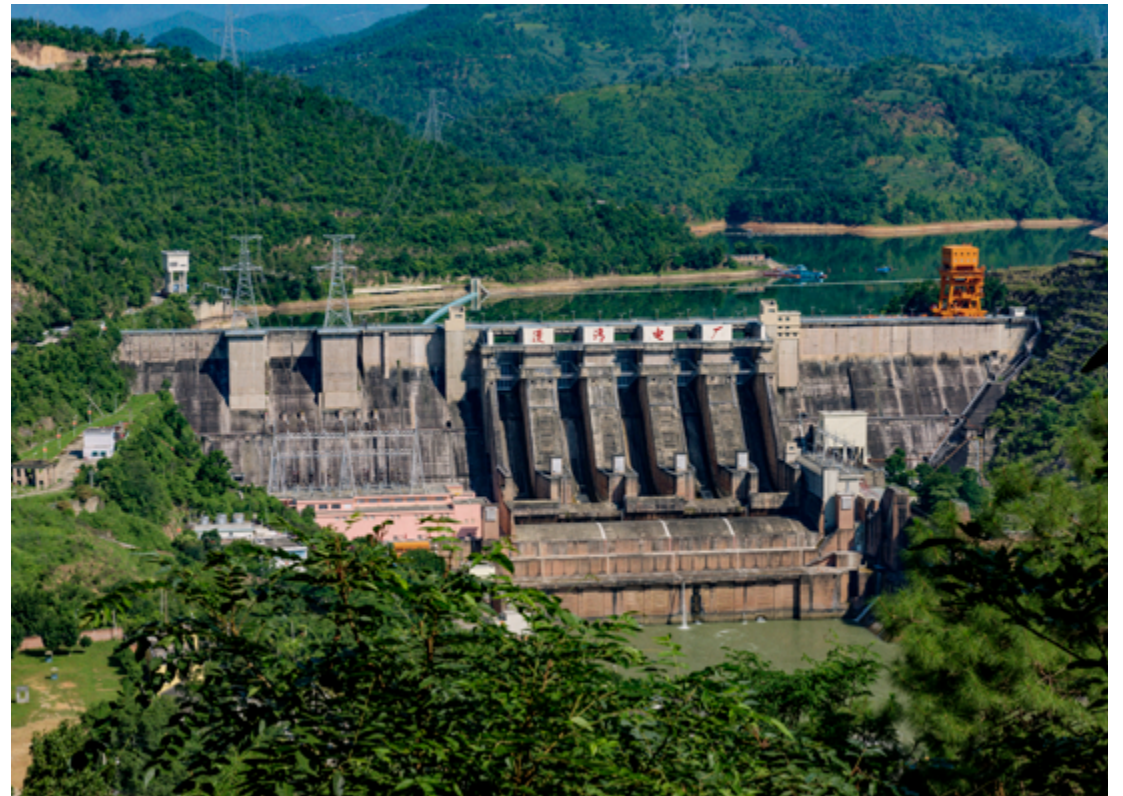
鸟瞰漫湾电站大坝 供图 / 华能澜沧江水电公司
