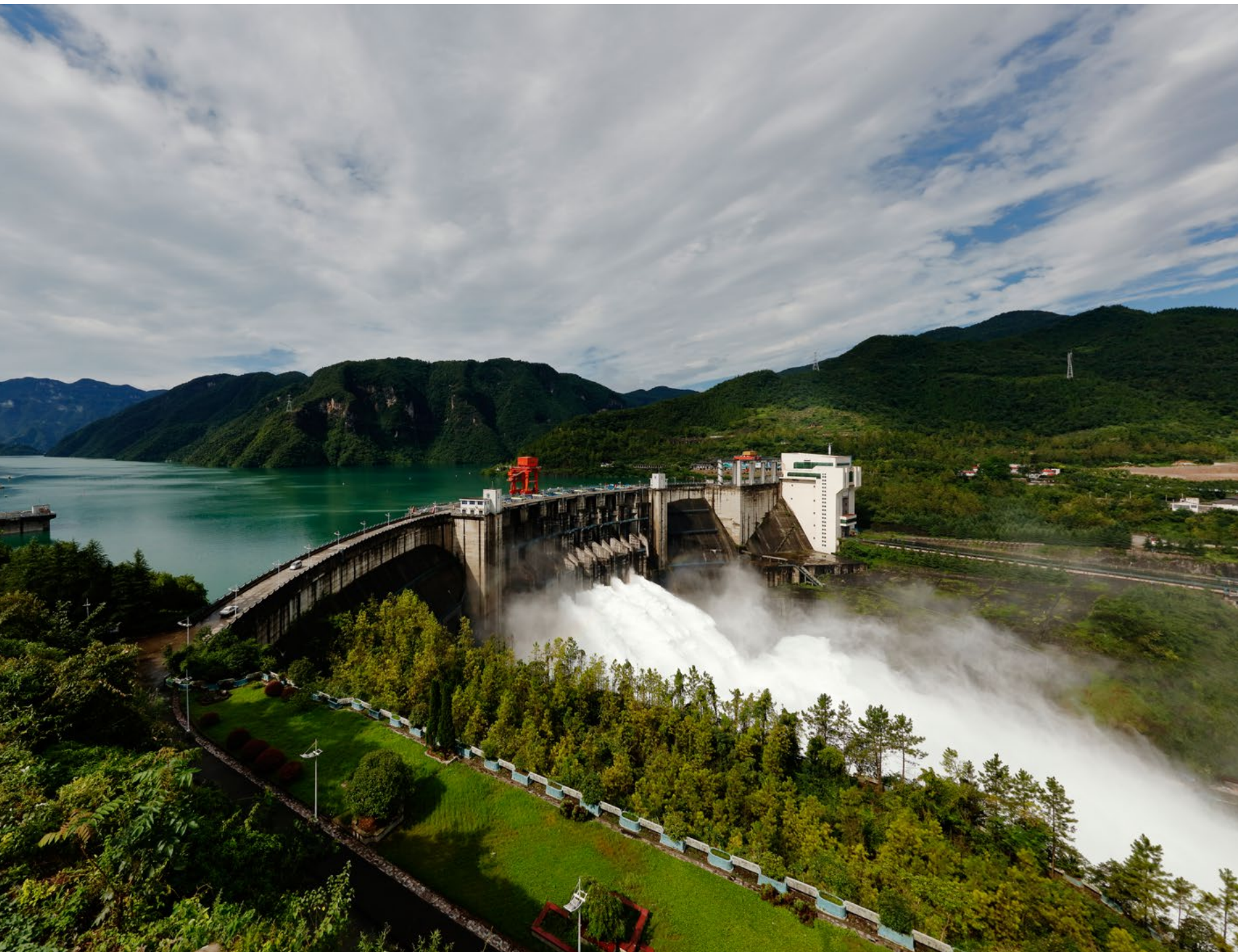
隔河岩大坝泄洪 摄影 / 吴晓阳
