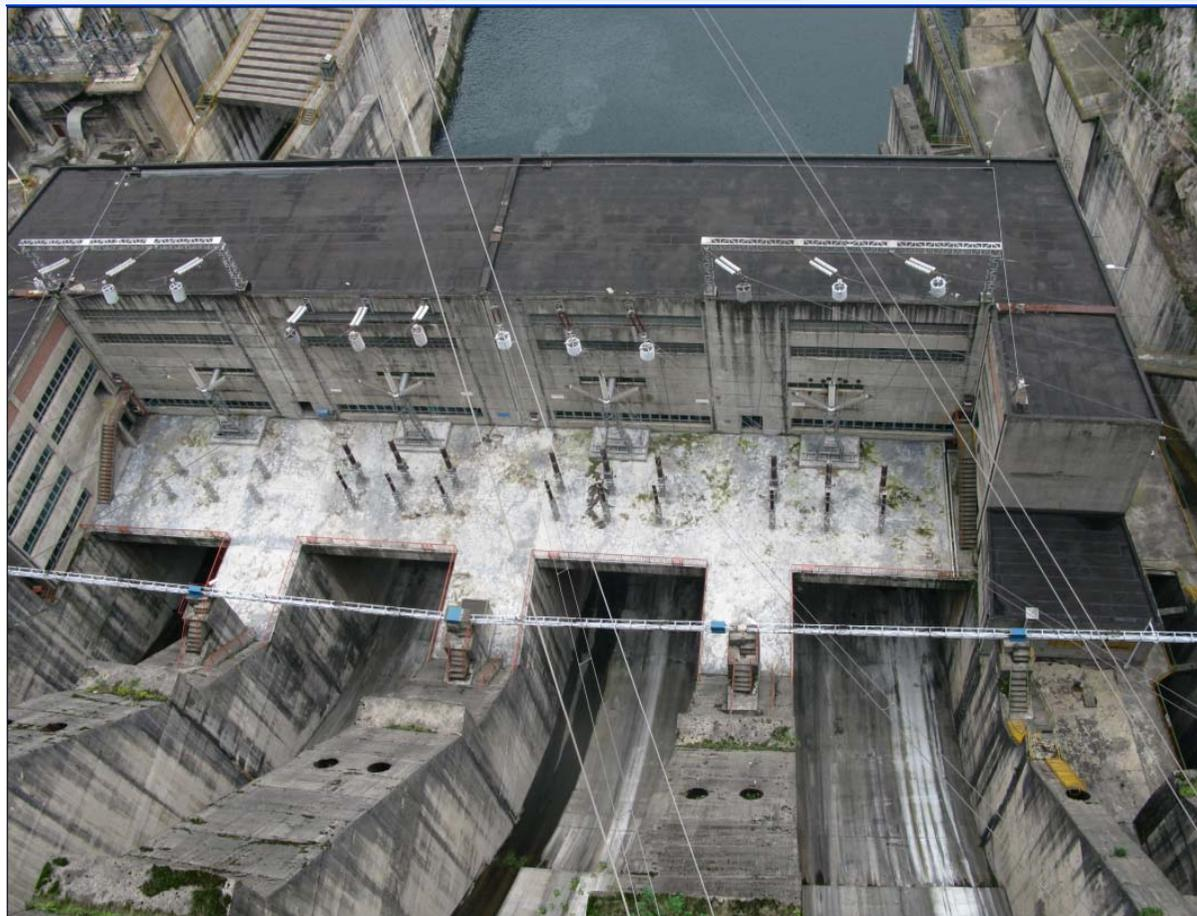
主厂房为全封闭式结构。开关站设于溢洪道末段导墙上，泄洪水流穿过开关站从厂房顶挑落至下游河床。
