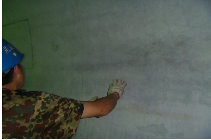
图3 第二仓拆模后混凝土表面效果
