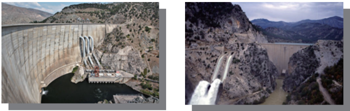
图1 70年代建设的Gökçakaya拱坝（左）和Oymapınar拱坝（右）
