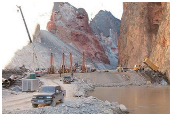
导流洞主体围堰合拢
