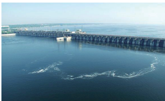
伏尔加格勒大坝下游面
