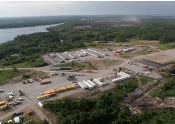
Lower Mattagami河水电站扩建项目施工现场
