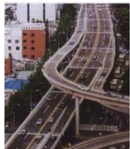
1976 年建起的 Cheongye 高架桥
