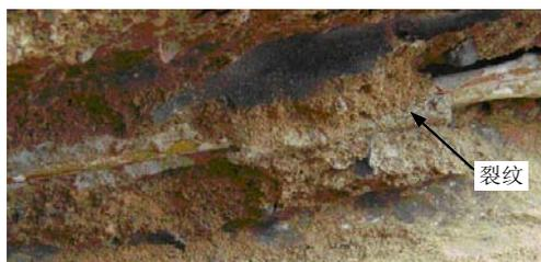
图 6 爆破在锚固结构中引起的裂纹
