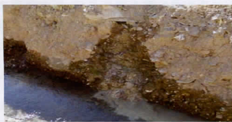
图4 桩号0+493处灌浆,探渗沟0+430处串浆
