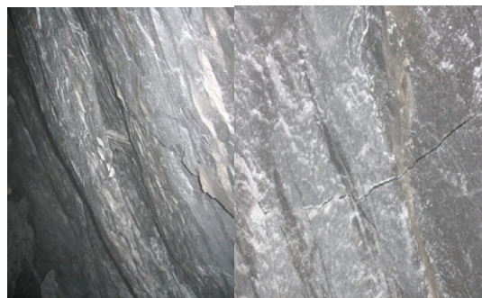
图 4 排水洞(K10+669.800)掌子面中部拉裂隙及板裂
